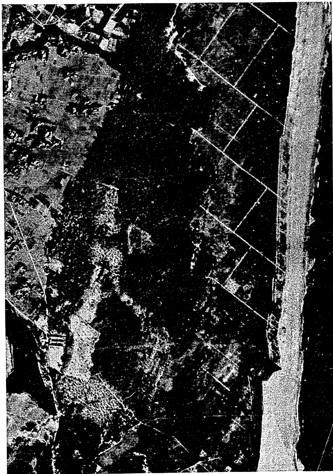
第 2 図 敷地航空写真(1)一(着工前)
