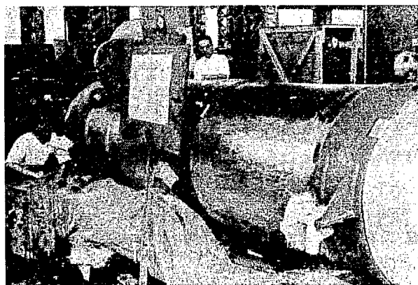
Photo 14. 主重水熱交換器
