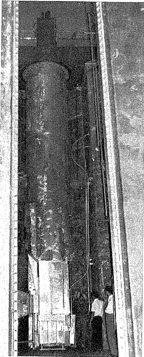
Photo. 3.3 炉心タンク (No.2 プール側からゲートを通してみる)
