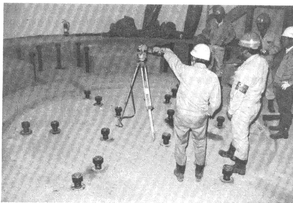
ピット内部芯出し
