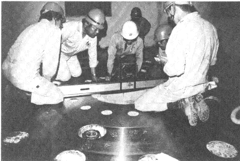
スラスト軸受用床板設定 レベルング立会 S. 58. 6. 7
