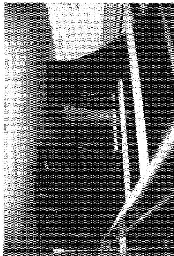
Photo. 6 遮蔽壁貫通スリーブ端末部分のケーブル通線状態の一例(ケーブル中継室の天井部分)。
