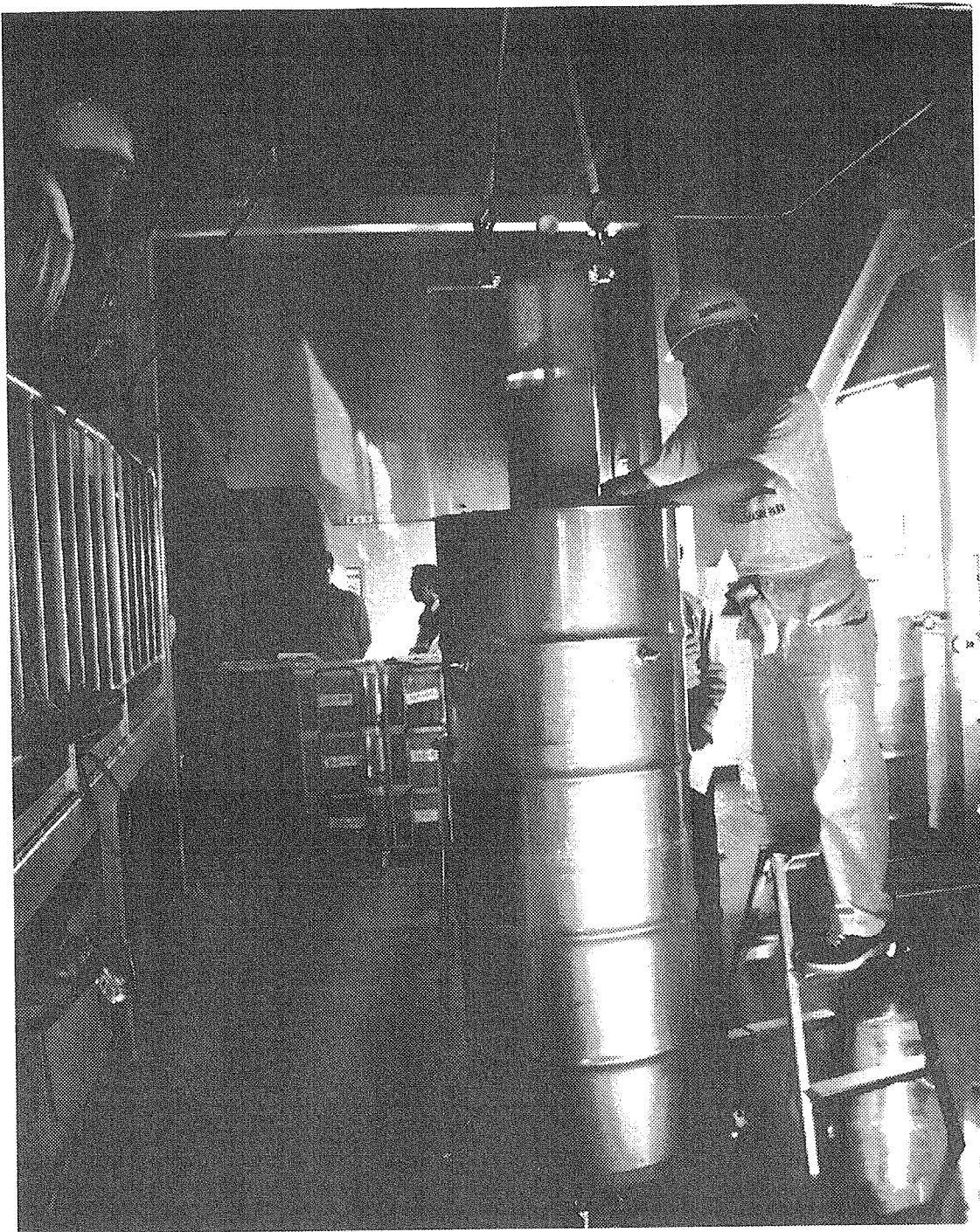
Fig. 13 樹脂筒を樹脂筒輸送容器に収納
