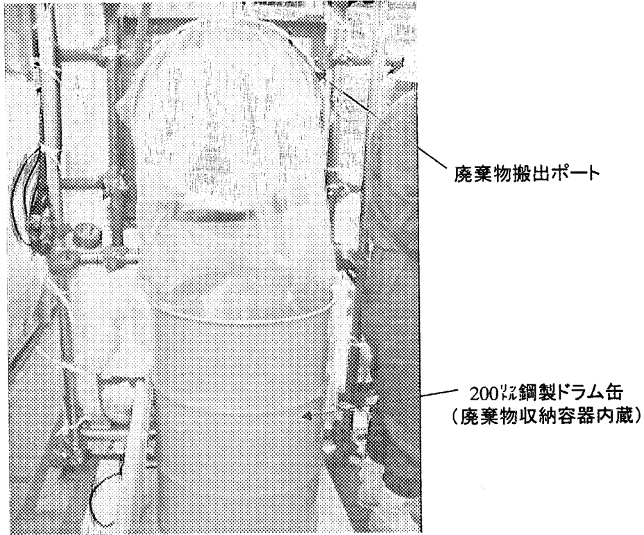
写真5.5 グリーンハウスの廃棄物搬出ポート
