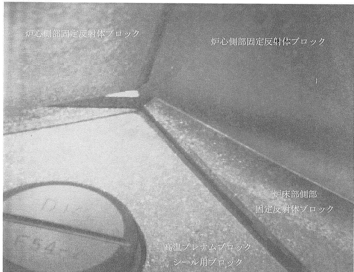
図 4.3 炉床部側部の固定反射体ブロックと隣接するシール用ブロックとの段差
