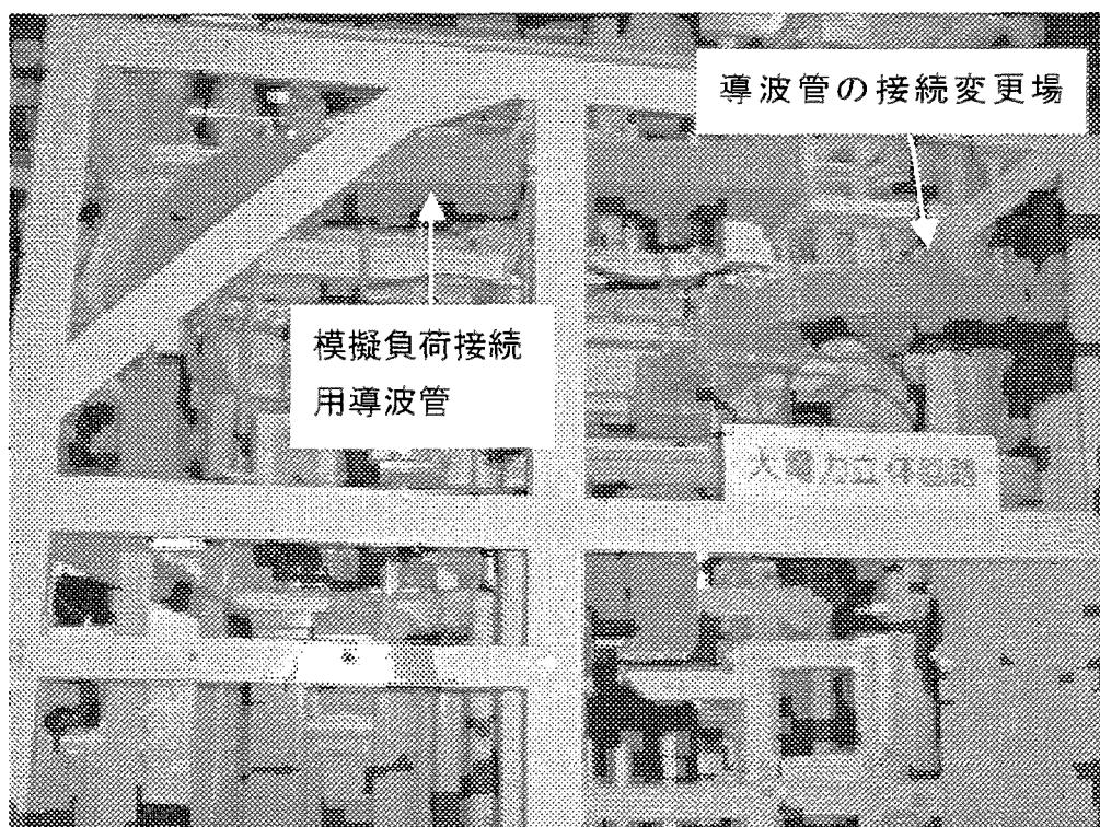
図2-6 導波管接続状態(真空容器側)
