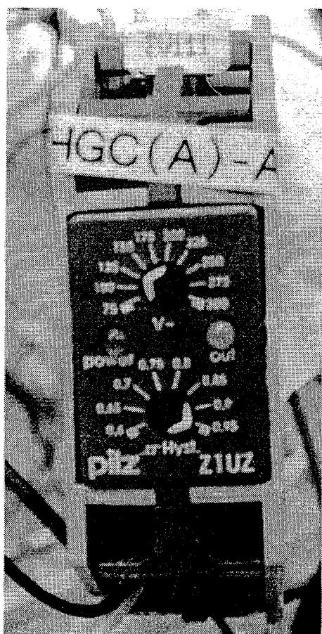
Fig.7 制御電源監視を行う補助リレーの動作概念図と外観
