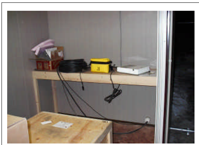
施工後：観測小屋内 ケーブル引込後 機器接続 1
