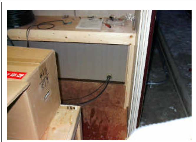
施工後：観測小屋内 ケーブル引込後
