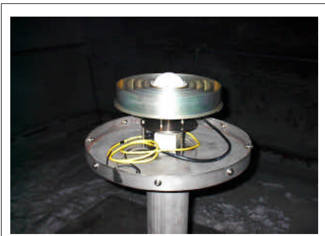
施工後:GPS アンテナ設置
