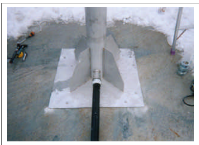
施工後：GPS アンテナ架台 配管敷設
