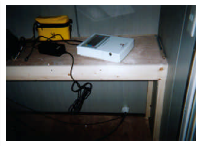
施工後：観測小屋内 ケーブル引込後 機器接続 2
