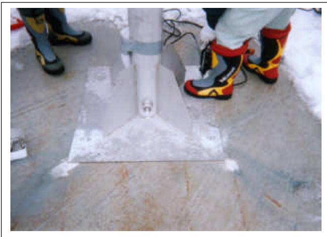
施工中:GPS アンテナ架台 装置アカ-設置
