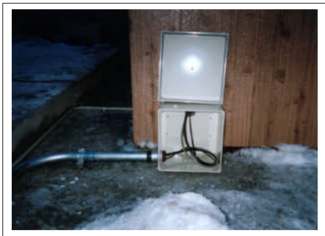
施工後：観測小屋 プルボックス設置
