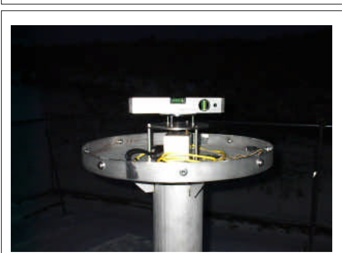
施工後：雲台水平調整 2
