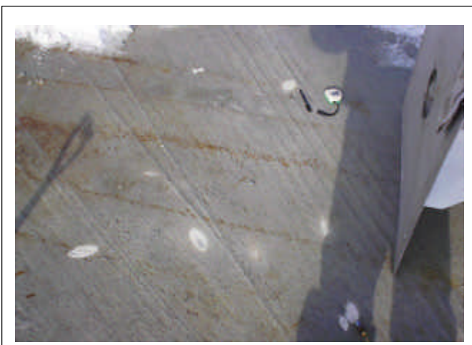
施工前:GPS アンテナ架台 装置設置場所 (位置出し)
