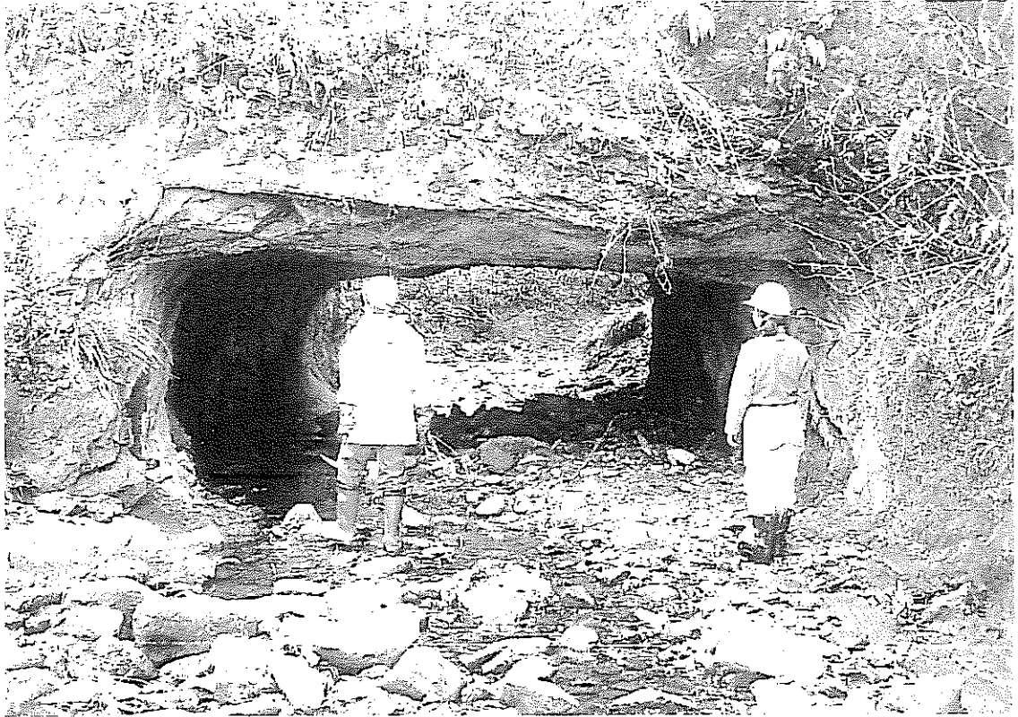
A-3 清澄層水路トンネル
