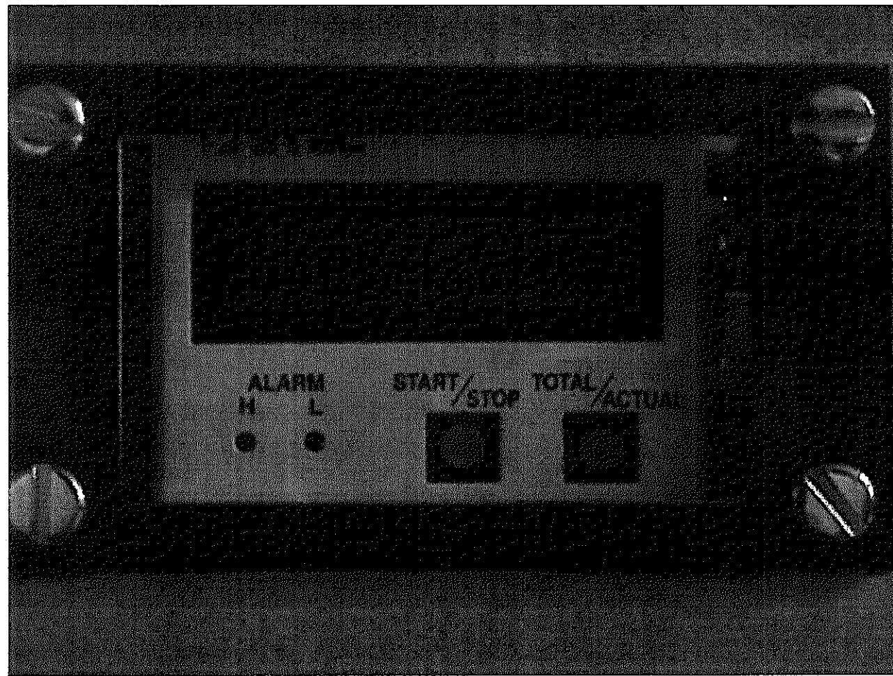
写真 3.7-13 流量計表示および操作部
