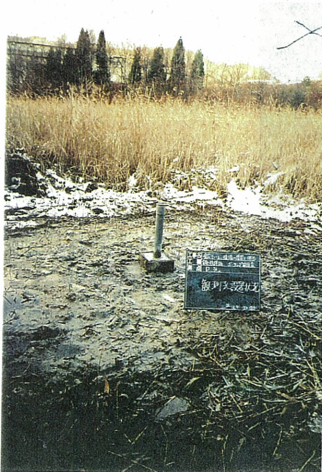
観測孔設置状況
