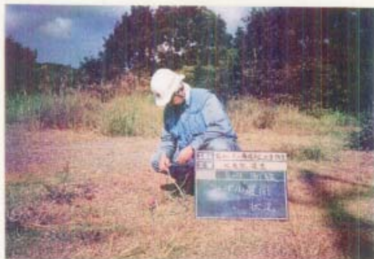
Ⅱ-1 測線 ケーブル展開状況
