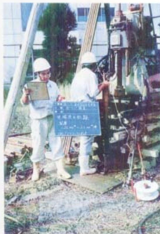
非定常法による透水試験状況
