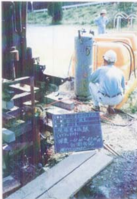
低圧岩盤透水試験状況
