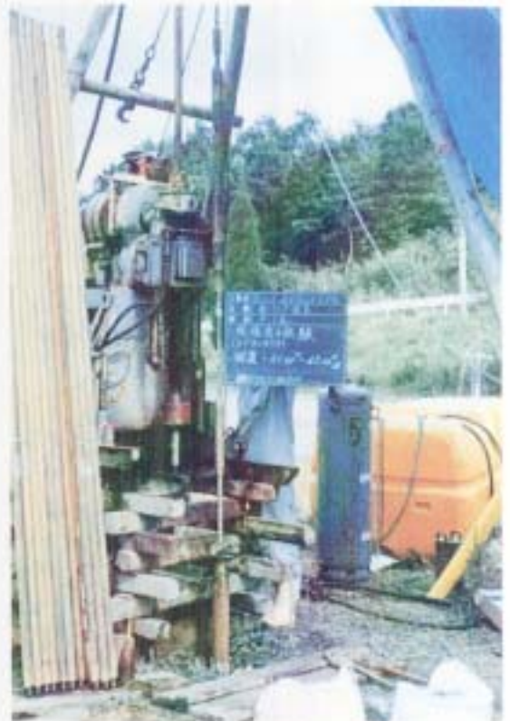
低圧岩盤透水試験状況
