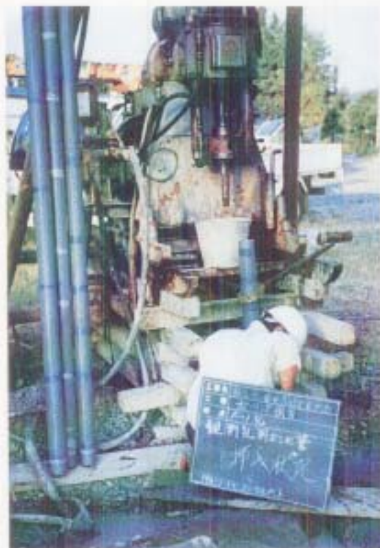
観測孔用塩ビ管挿入状況
