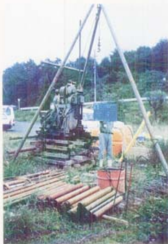
ボーリング地点全景
