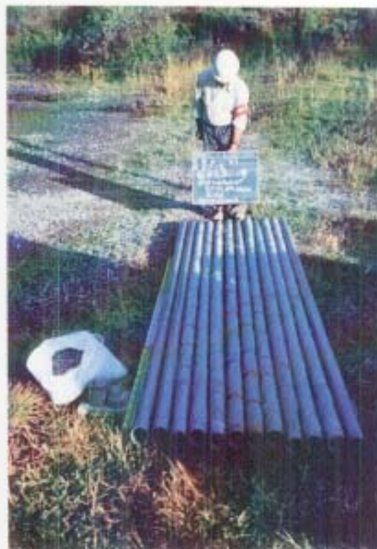
観測孔用塩ビ管全景
