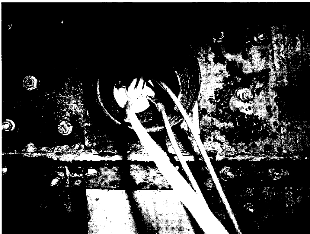
写真3.2-10 パッカー式プローブ挿入状況 2 (白いチューブは空気注入用, 灰色の 2 線は同軸ケーブル)
