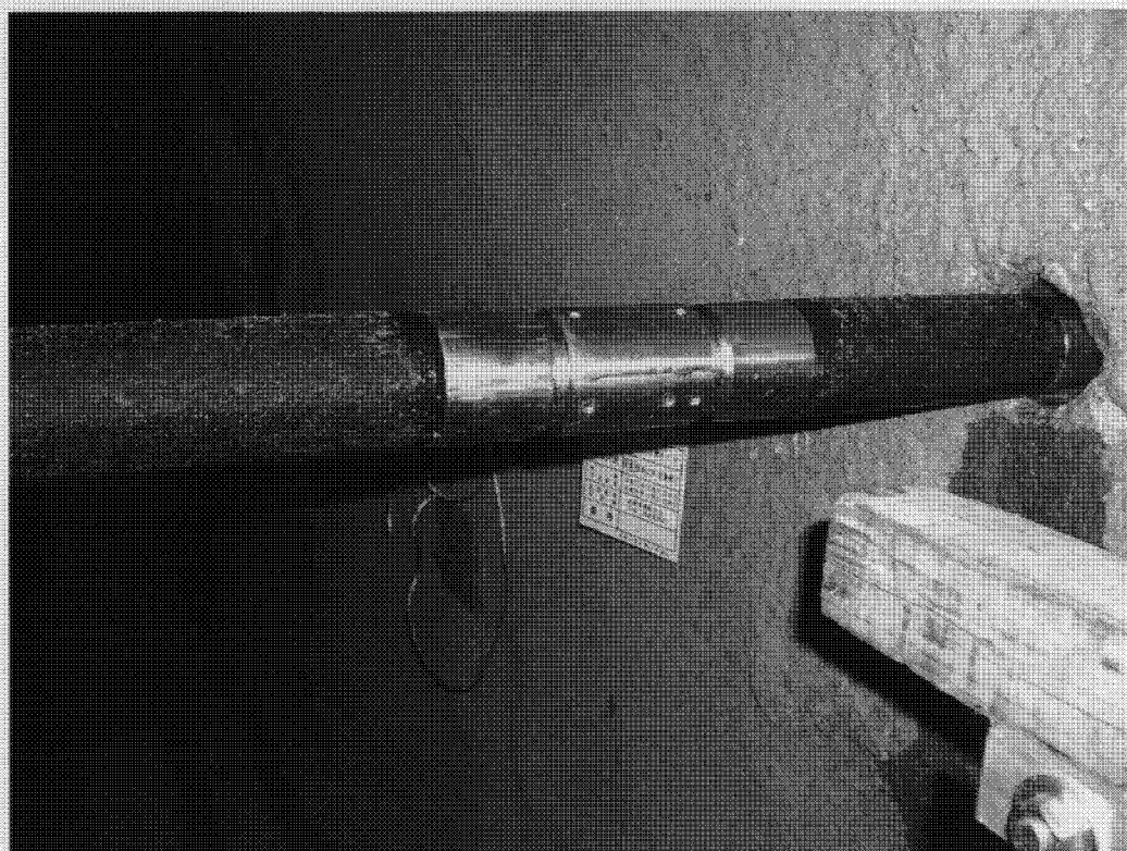
写真10 パッカー回収（表面に砂質分付着）
