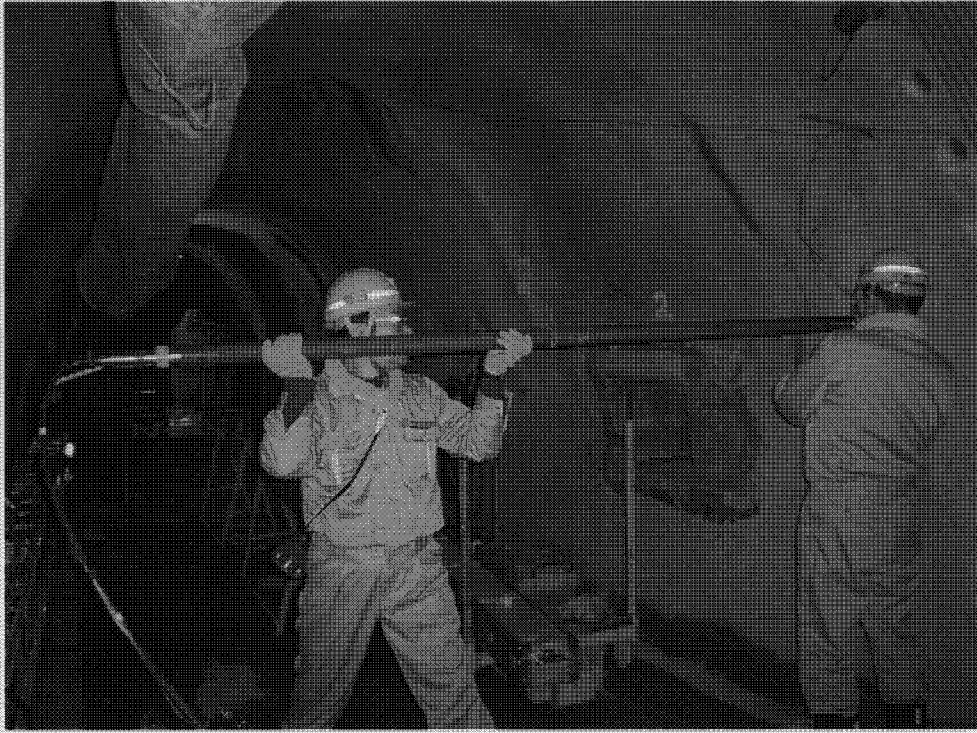
計測用ゾンデ挿入状況 (03SI-20)
