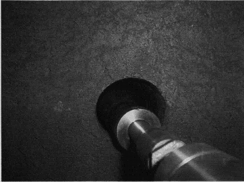
止水パッカー設置状況 (03SI-19)
