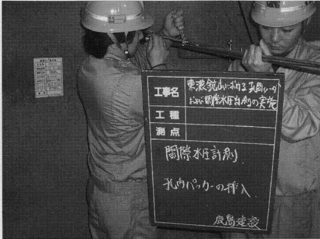
写真3 パッカー挿入
