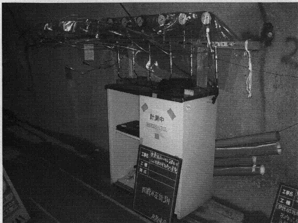
写真9 間隙水圧計測
