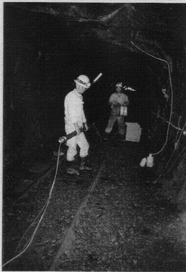
写真-11 バッカー設置準備
