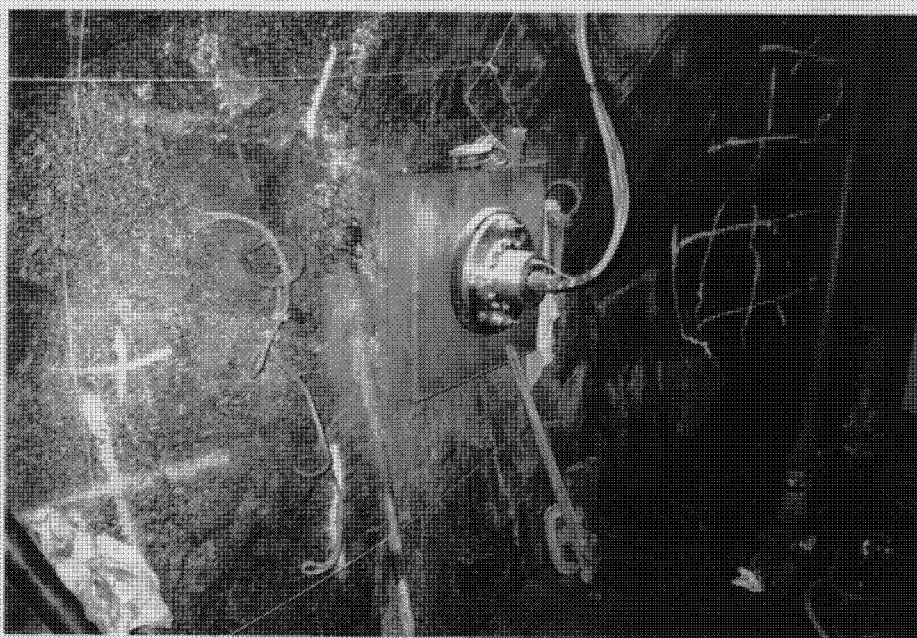
写真-20 装置設置完了状態
