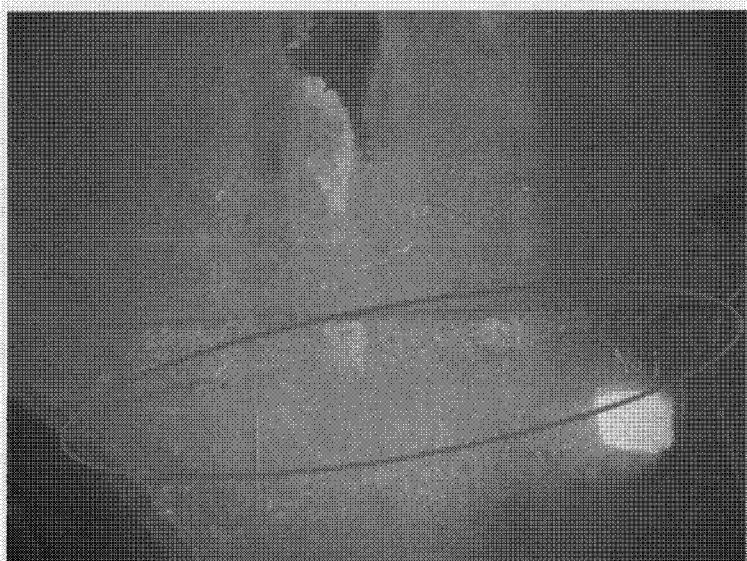
写真 4-4 横坑接合部付近のひび割れ
