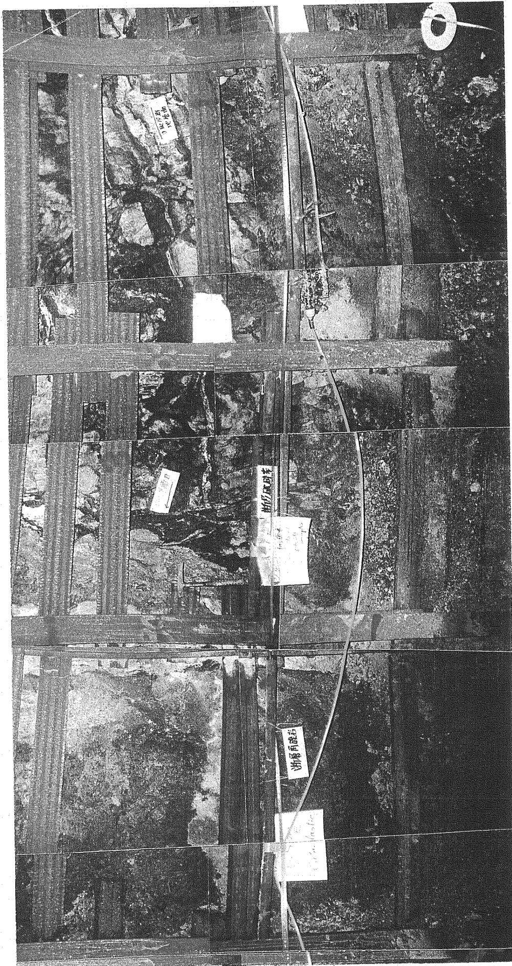
写真 2. 3. 1 活断層調査坑道の断層露頭 (B 破砕帯)
