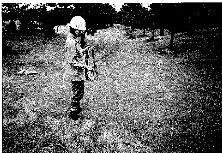
写真-4 ケーブルの展開状況
