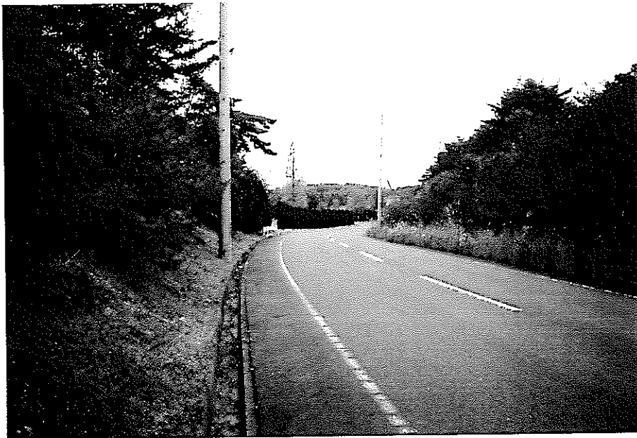
写真-7 測線距離250m付近より終点側を望む 測線位置は道路沿い
