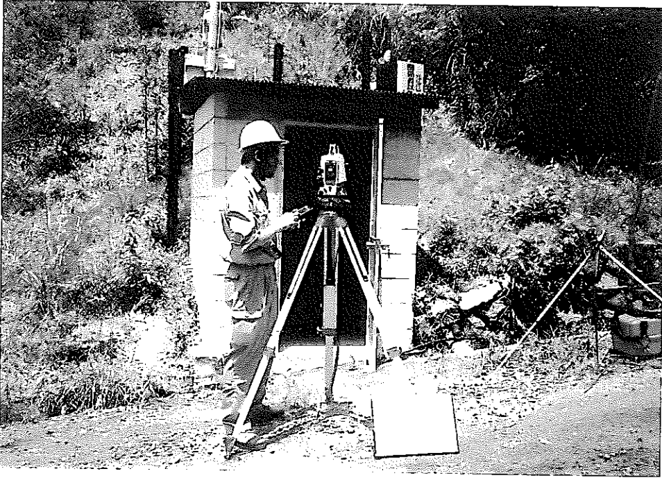
写真-11 取り付け観測（トータルステーションによる座標測定）
