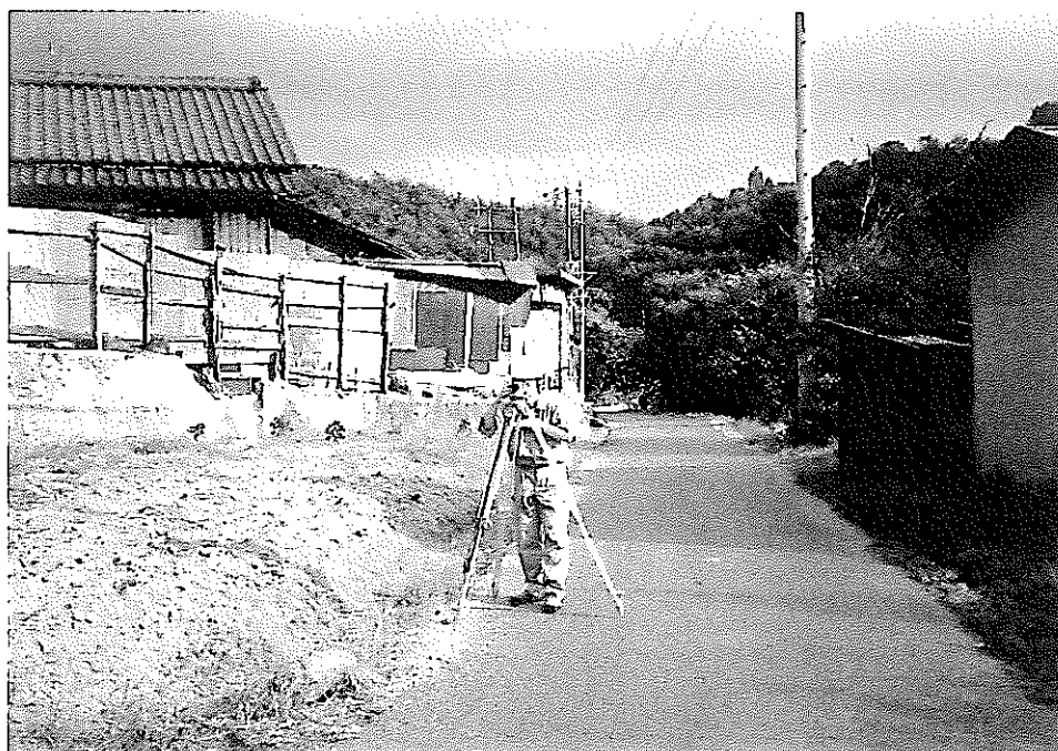
写真-14 水準測量（レベルによる高さ取付け観測）
