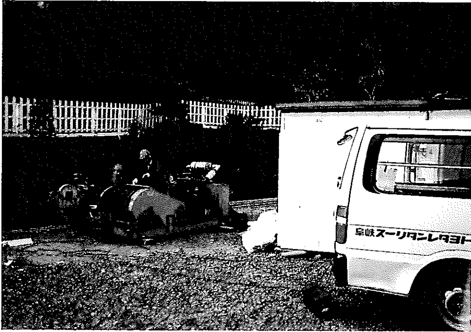
写真 2. 7 ウィンチ操作作業
