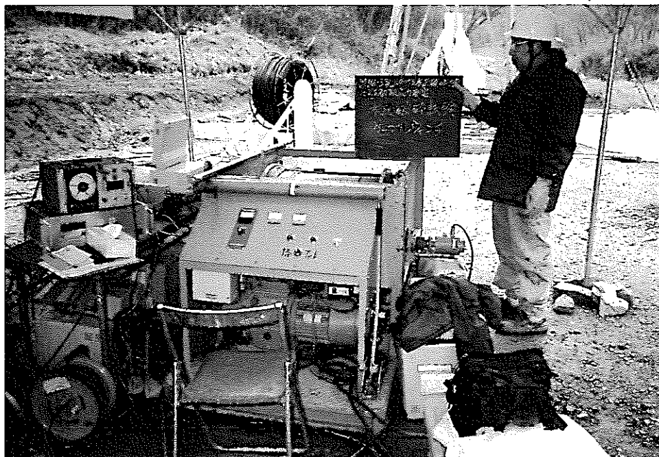
水圧破碎用ケーブル ウィンチ
