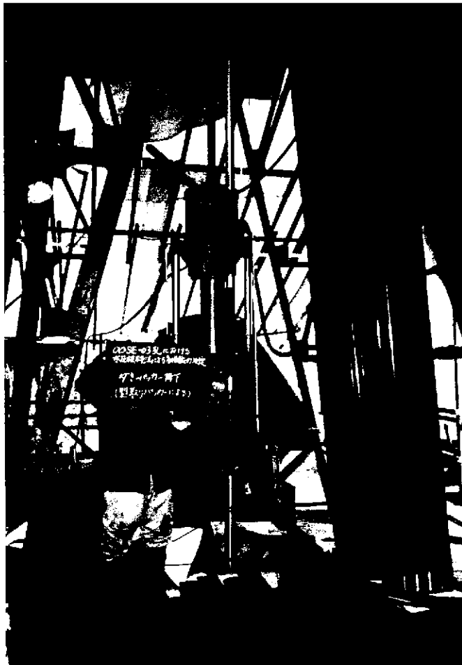
ダミーパッカー降下 (型取りパッカーによる)
