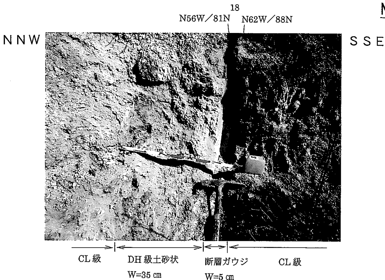
P-21 割れ目 18 の状況
