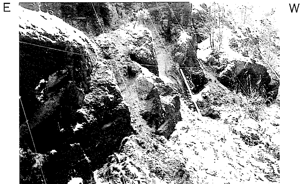
P-13 露頭面に斜交したNE走向，NW～垂直～SE方向の傾斜を示す割れ目。4～20 cm間隔で分布する。割れ目面を境にDH級／CL級となる割れ目あり。グリッド間隔1 m。
