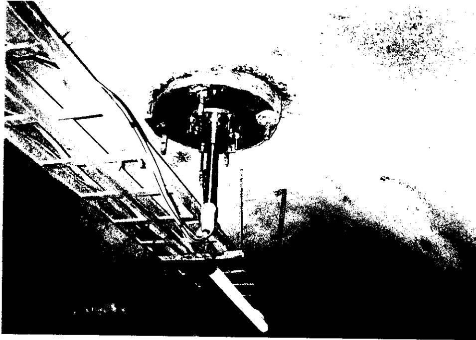
写真19 孔内部、孔口マニホールド設置完了状況
