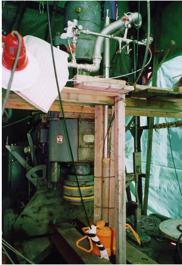
写真-4.6.11 揚水試験状況（第1回試験）
