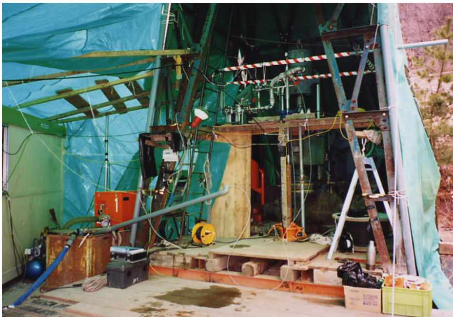
写真-4.6.12 揚水試験状況（第2回試験）
