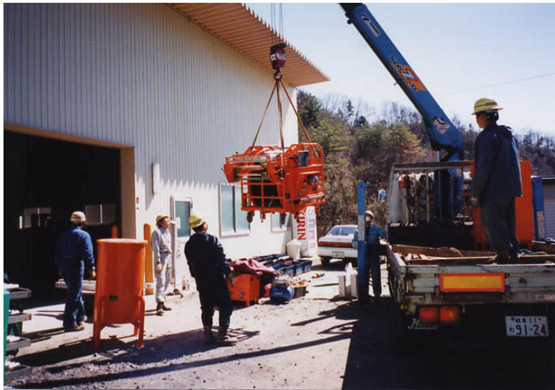
写真-4.6.18 搬出作業
