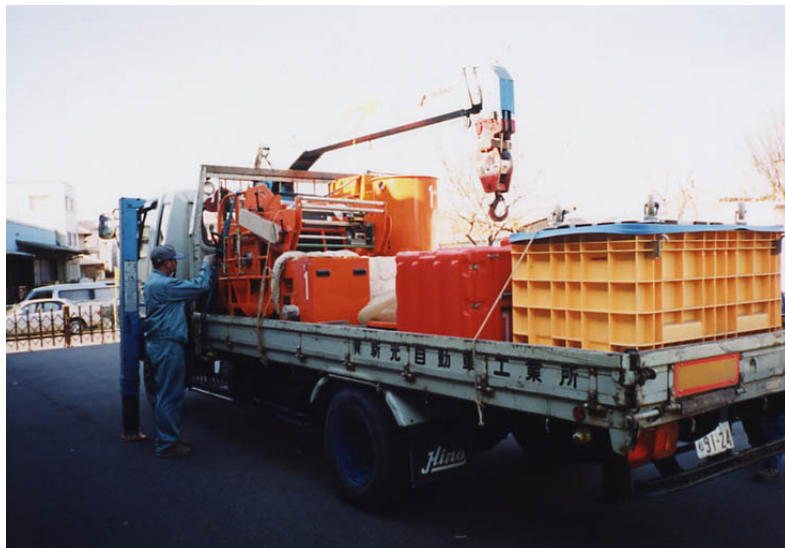
写真-4.6.19 搬出作業（土岐倉庫）
