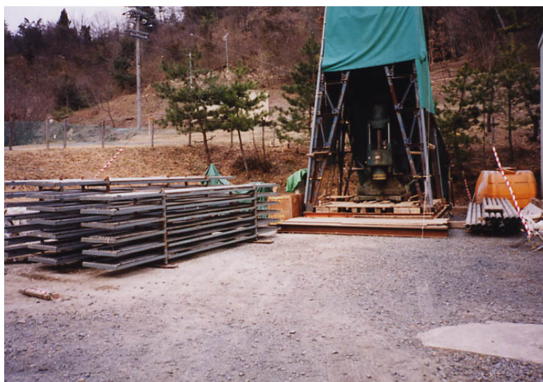
写真-4.6.20 完了状況
