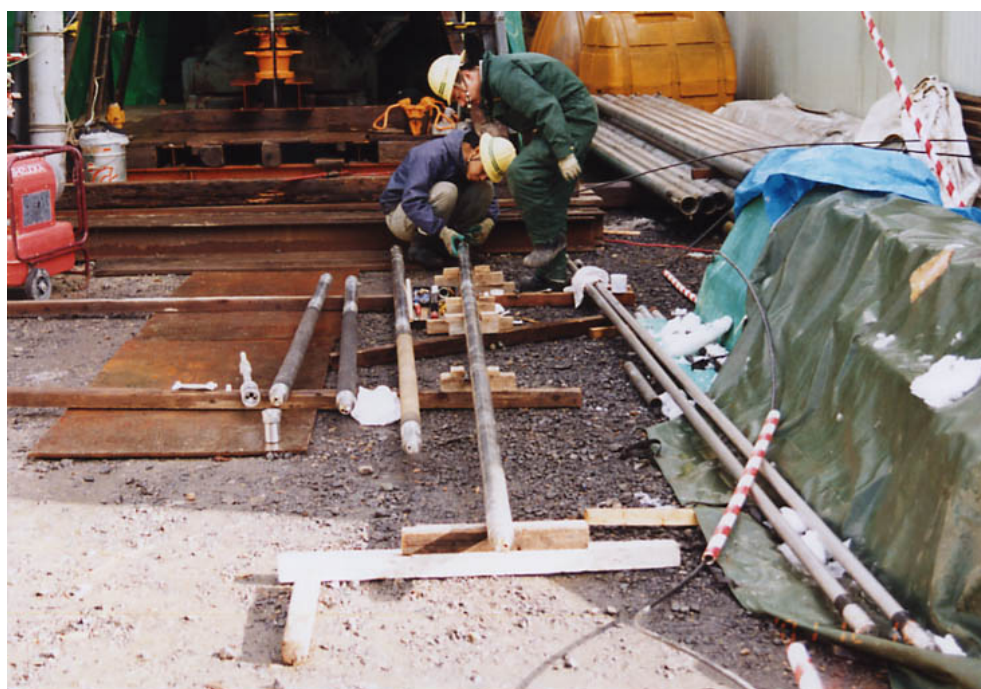
写真-4.6.4 ゾンデ組立（第1回試験）
