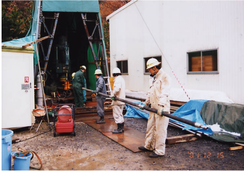
写真-4.6.6 パッカー挿入（第1回試験）
