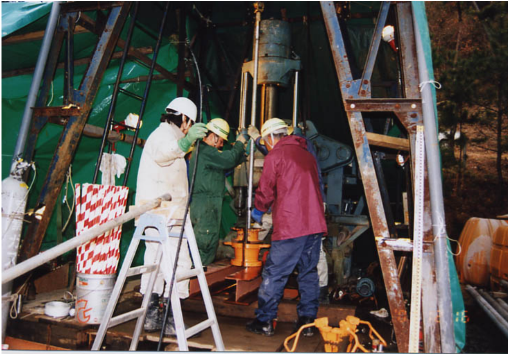
写真-4.6.10 ロッド挿入（第1回試験）
