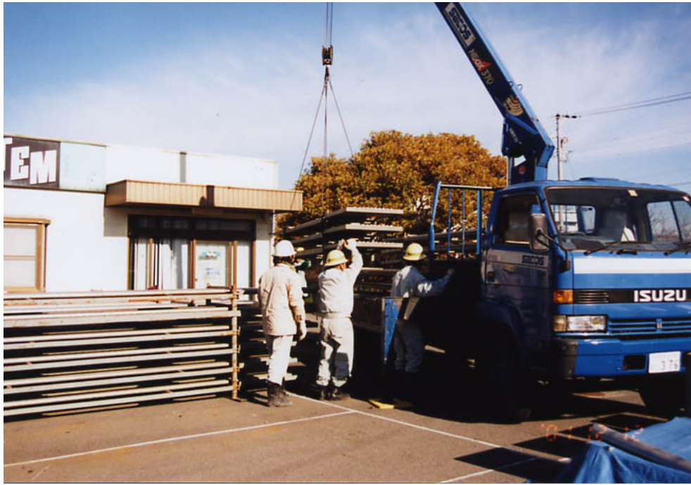
写真-4.6.1 搬入作業（土岐倉庫）
