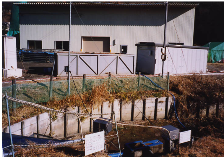
写真-4.6.14 揚水後の河川放流状況
