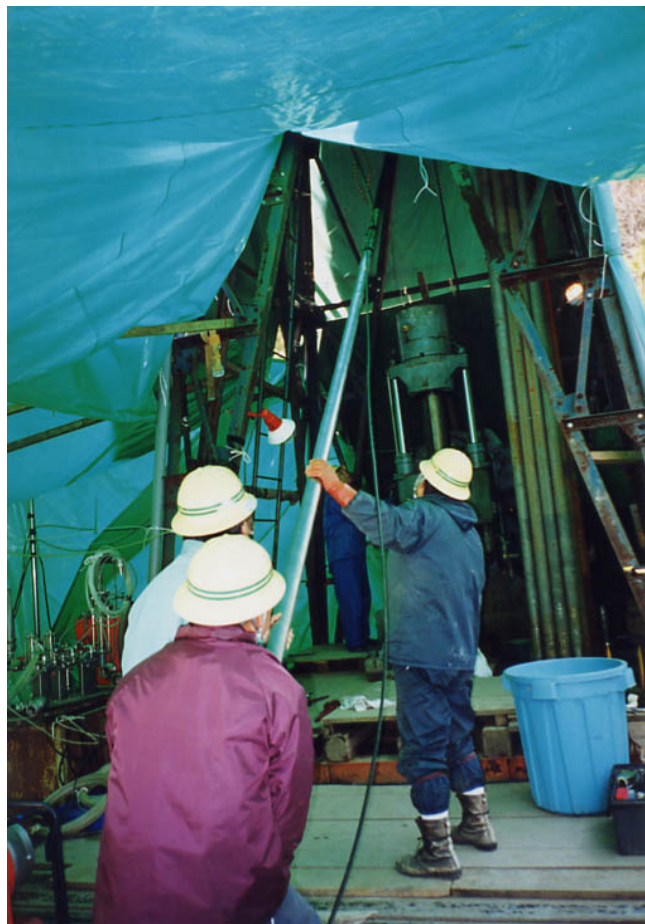
写真-4.6.9 ゾンデ挿入（第2回試験）
