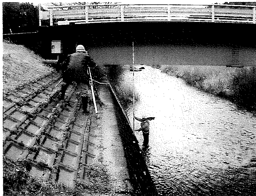
写真 付4-7 水位標1m位置測定
