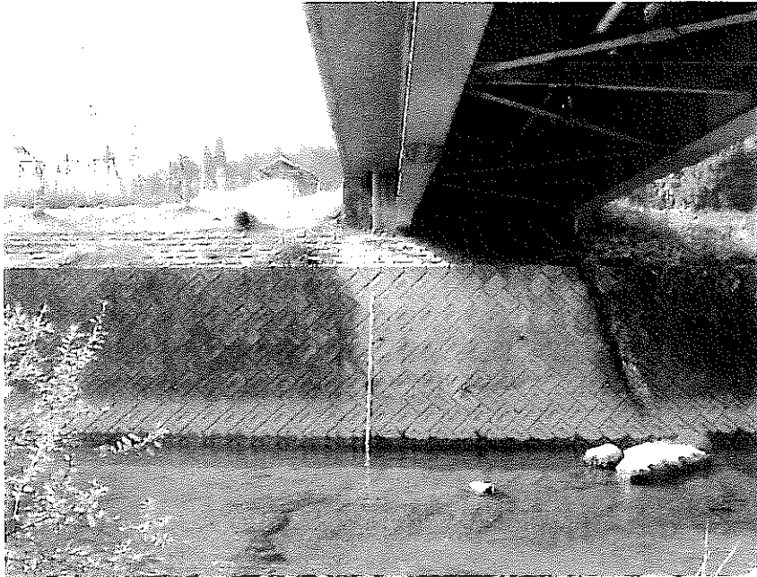
写真 2-7 B 地点 (右岸側状況)
