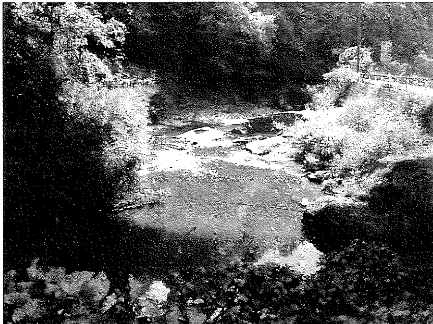
写真2-15 D地点 (下流側状況)
