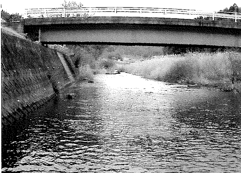
写真2-17 工事着手前 (下流より上流を望む)
