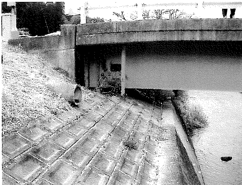
写真2-18 工事着手前 (下流より上流を望む)
