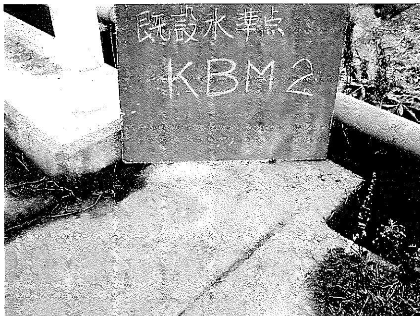
写真 付4-4 既設KBM. 2 (近景)
