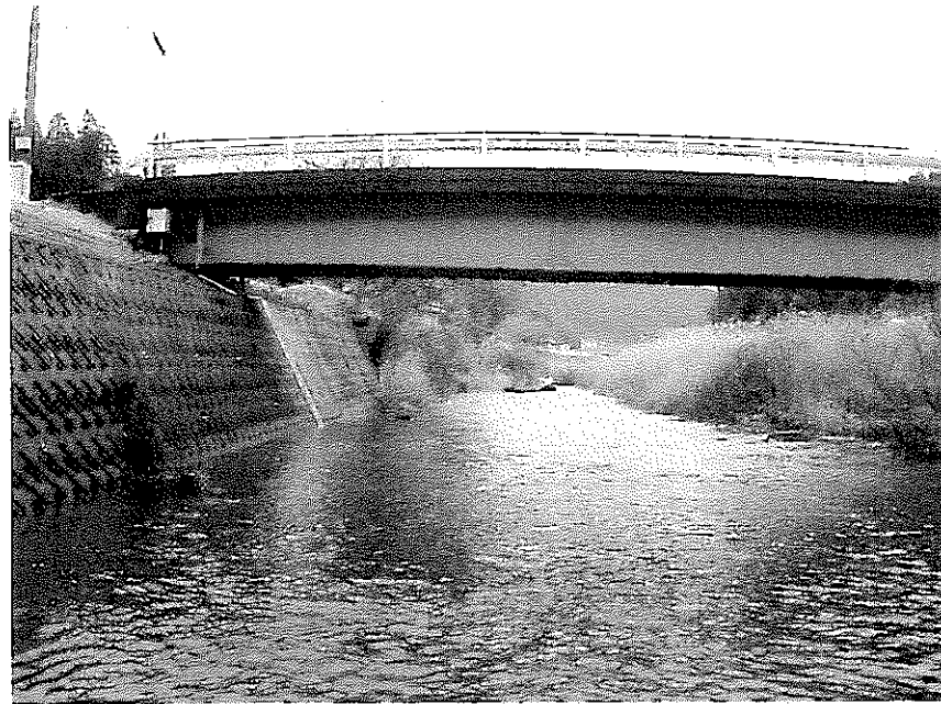
写真2-20 工事完了後 (下流より上流を望む)
