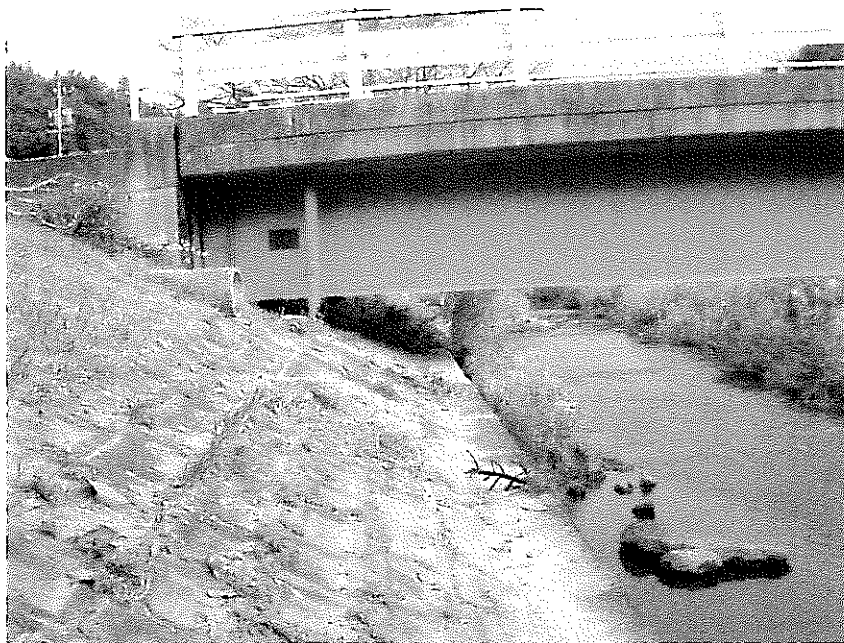
写真 2-8 B 地点 (右岸側上流面護岸状況)
