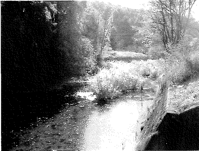
写真2-12 C地点 (下流側状況)
