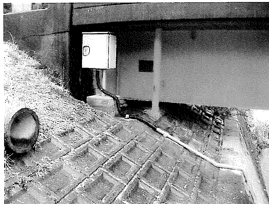
写真2-21 工事完了後 (下流より上流を望む)
