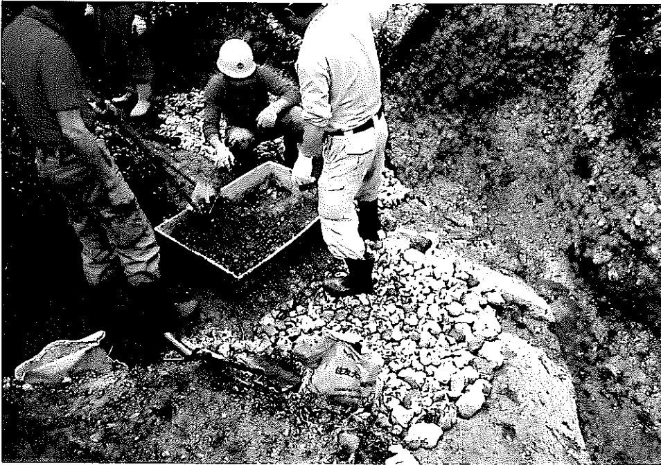
ベース コンクリート作業 (土留め堤防)
