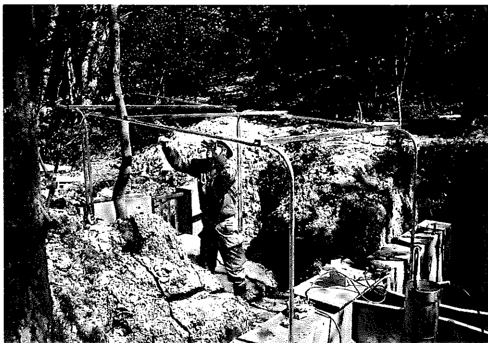
防葉ネット取付作業
