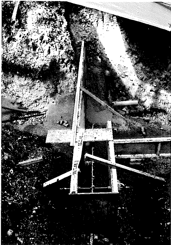
パーシャルフリーム (大) 型枠作業
