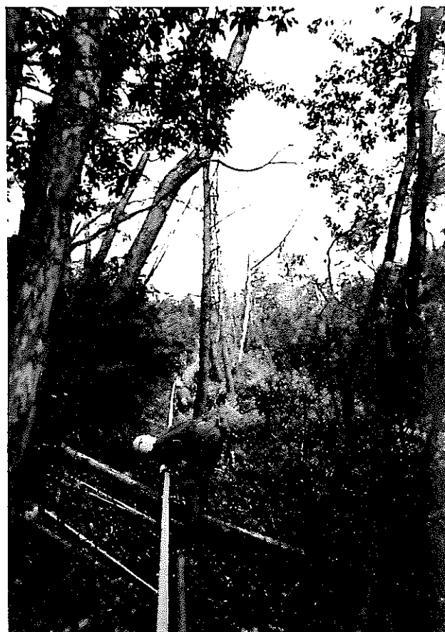
モノレール架設作業
