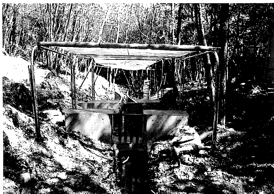
設置完了 全景 (上流より)
