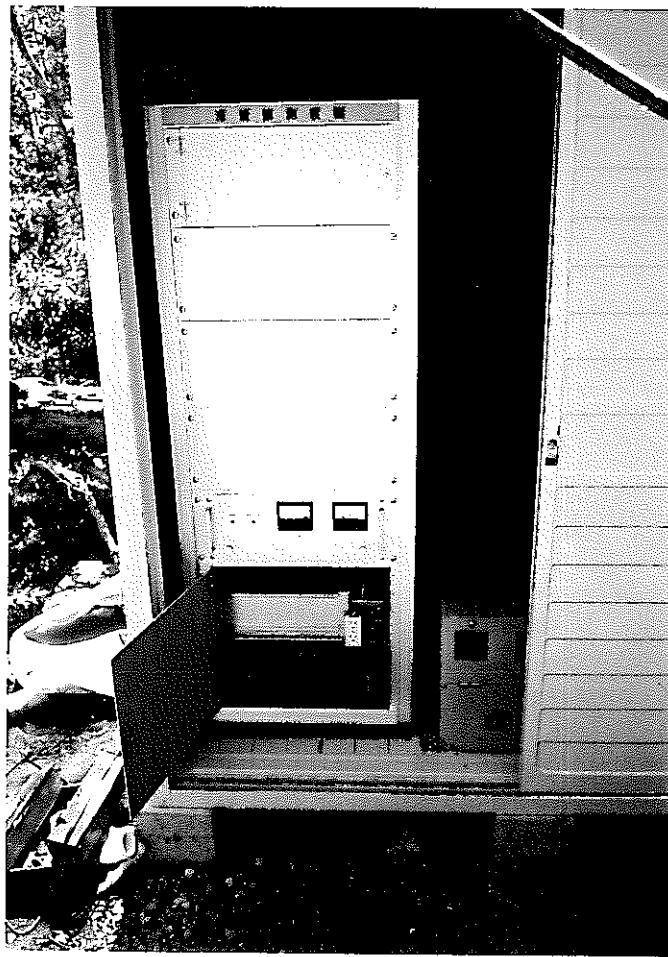
観測小屋設置完了、 流量観測装置設置完了
