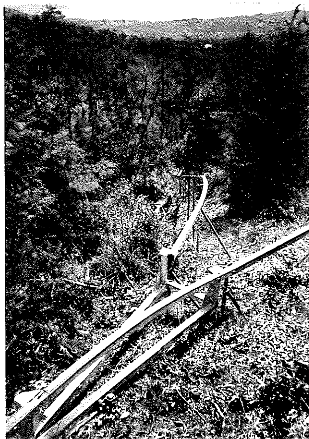
モノレール架設状況
