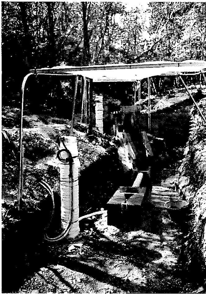
設置完了 全景（下流より）
