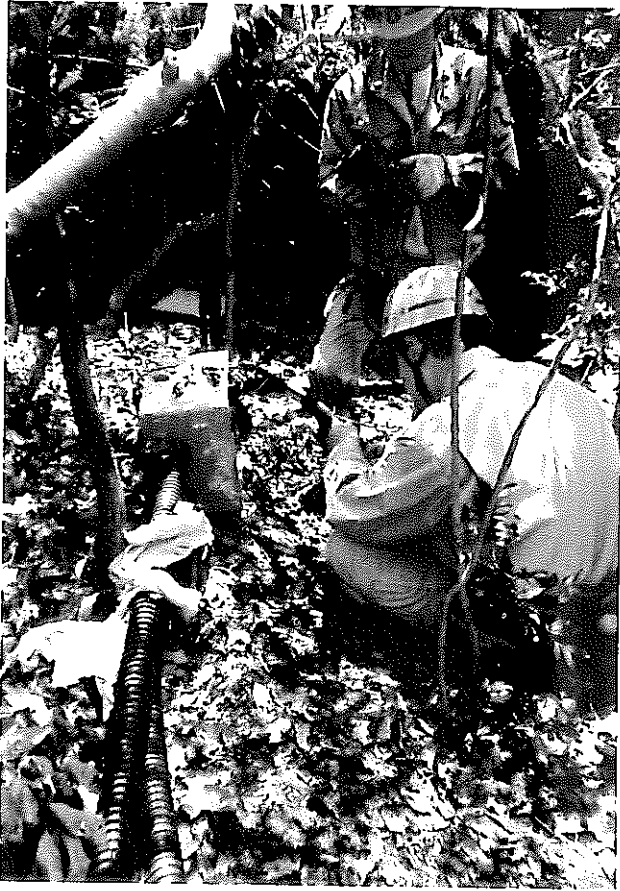
電力線分岐作業
