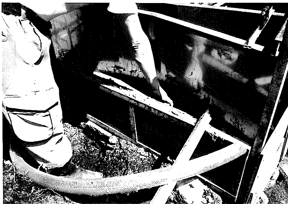
パーシャル フリーム（大） コンクリート打設
