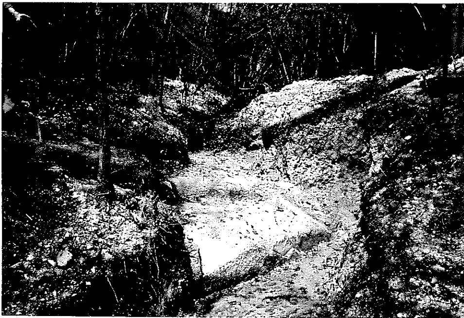
設置前 (河床整形後)
