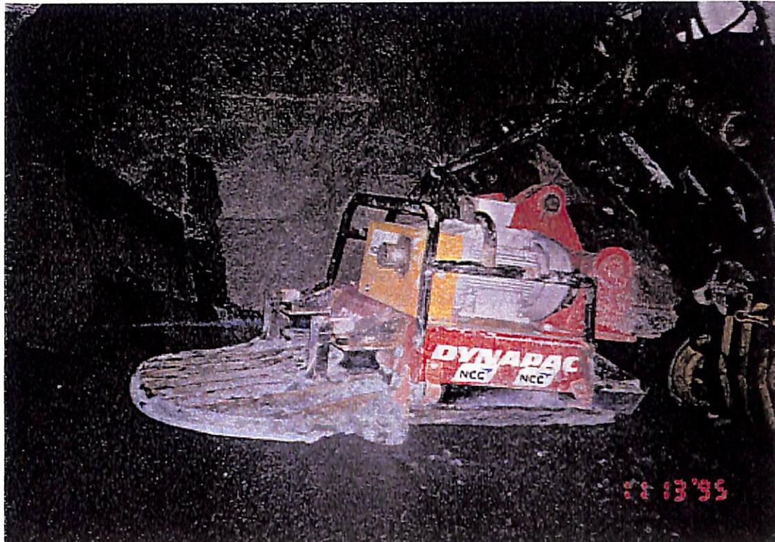
図-3. 3 SKB による振動締固め装置
