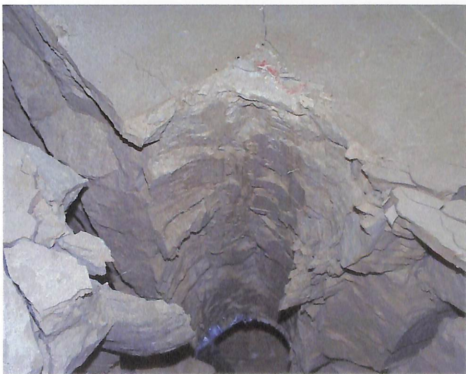
模型実験載荷装置 トンネル壁面状況
