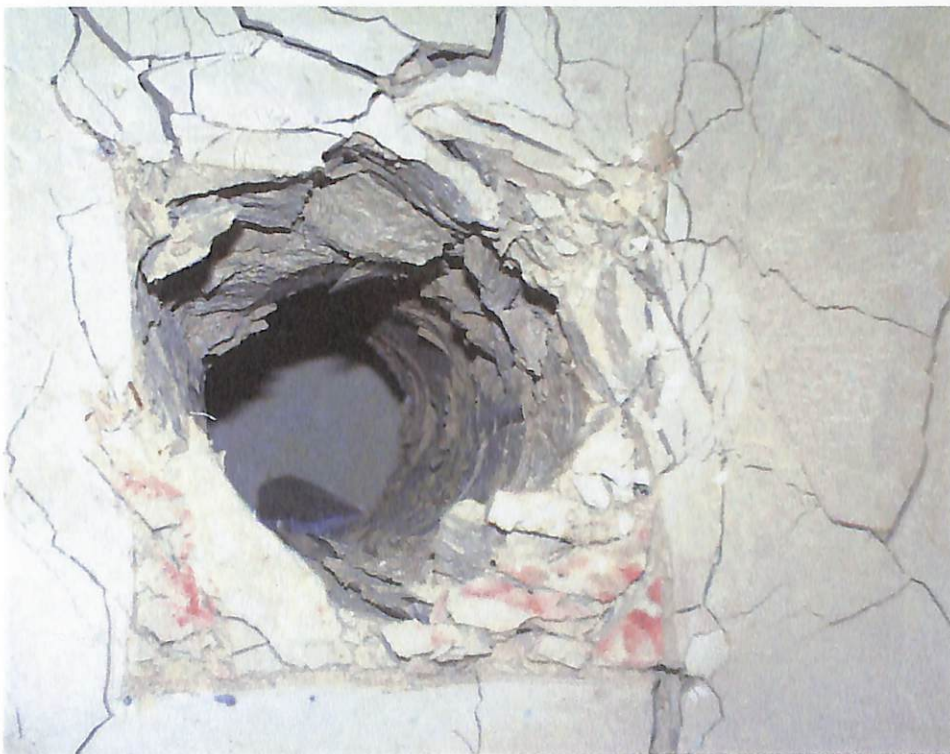
模型実験載荷装置 最終載荷・トンネル破壊状況
