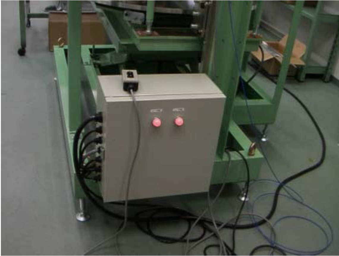
図 3.1-10 電源ユニット
