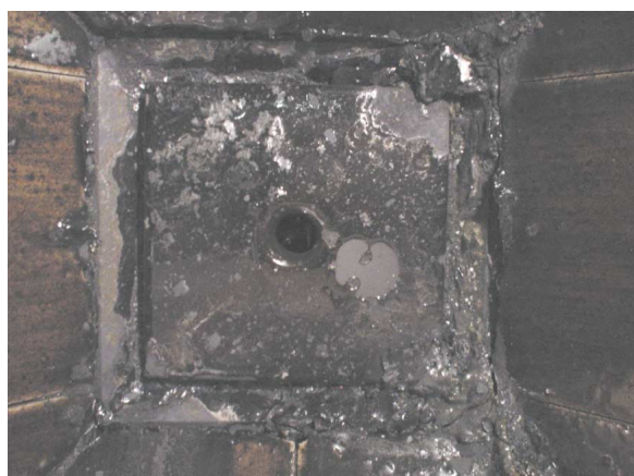
写真3 ドレンアウト後の底部状況
