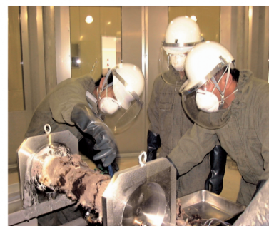
漏えい後の配管解体研修状況
