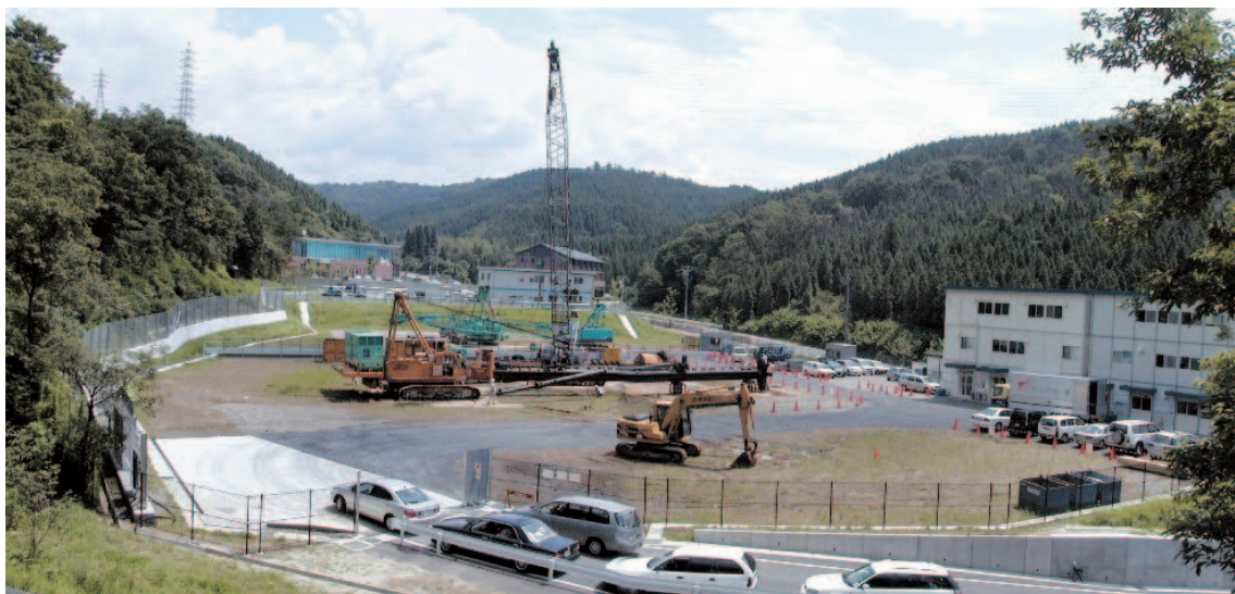
写真1 研究坑道掘削準備状況
