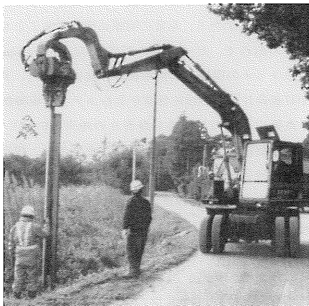
写真1 Long Geo-Slicer の鉛直打設作業
