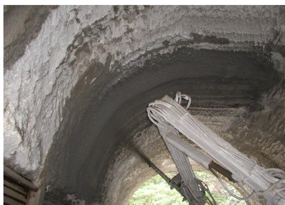
図 4.2-2 吹付けコンクリートの模擬施工状況
