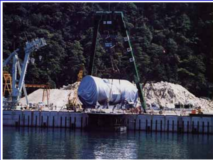
写真4-15 吊り上げられた原子炉容器
