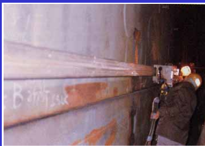
写真1-7 自動溶接(生体しゃへい壁)
