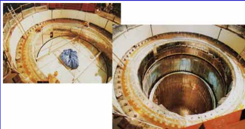
写真4-18、4-19 ガードベッセル養生蓋取り外し作業 (14:00～14:08)
