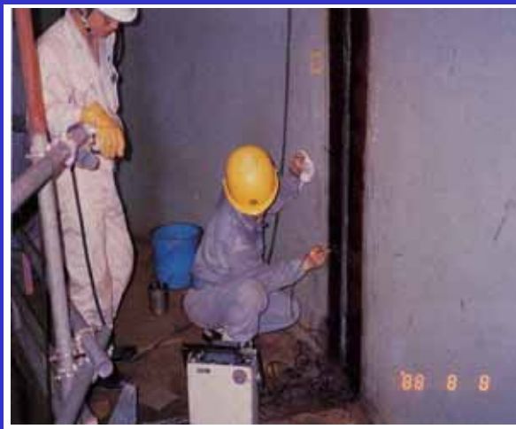
写真1-9 超音波探傷検査
