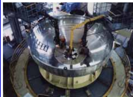
写真4-10 下部サポート溶接
