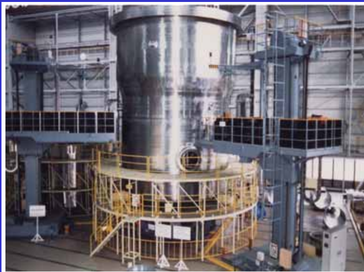
写真4-12 上部胴・中間胴溶接
