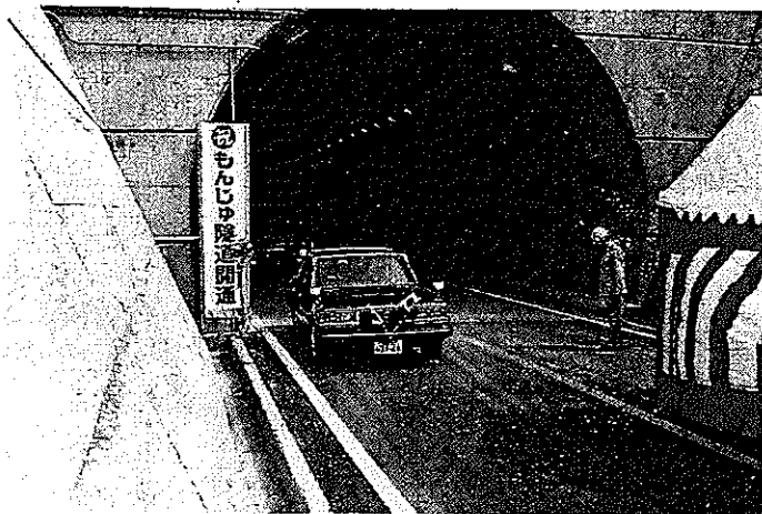
もんじゅ隧道開通(昭和60年3月)
