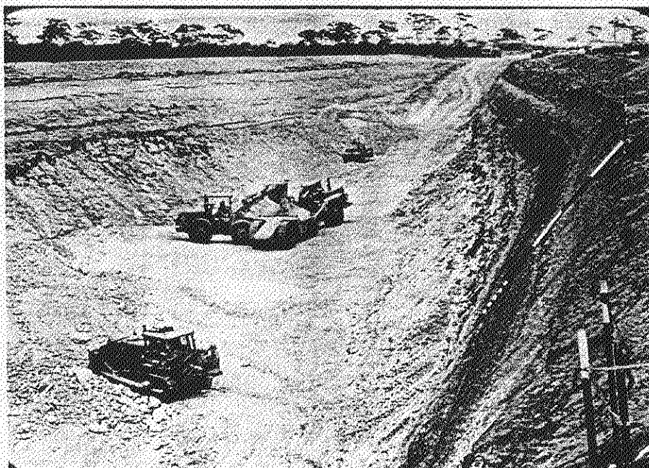
写真-⑩ ピット内掘削作業風景
