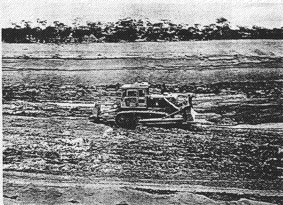
写真-⑨ D9によるリッピング作業
