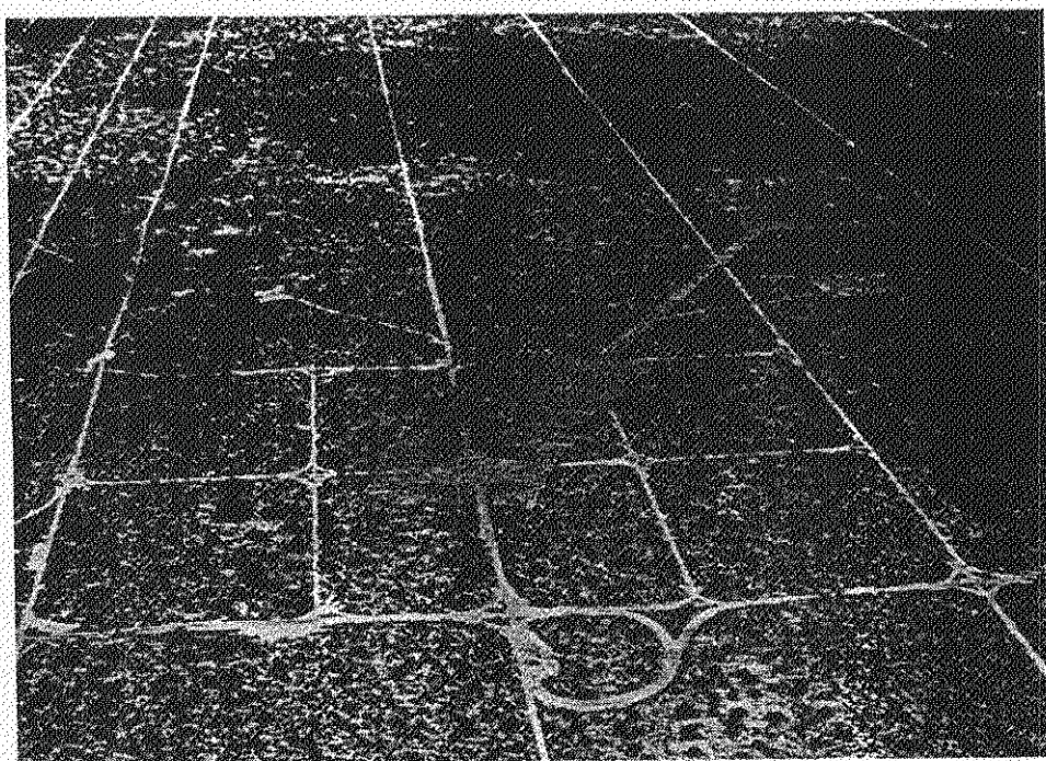
写真-① ピット予定地
