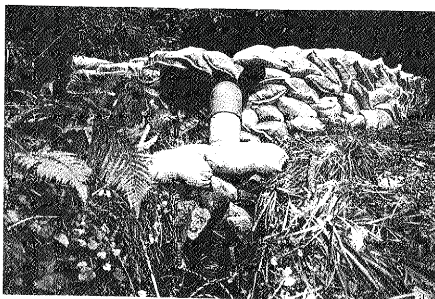
排水呑み込み口
