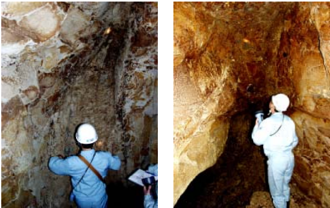
図10 地下壕で確認された断層露頭
