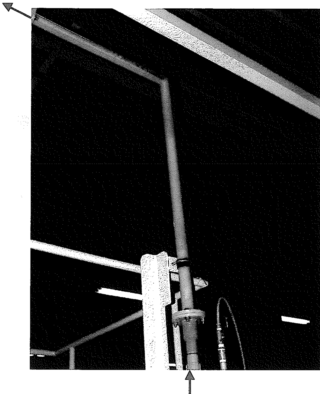
図5.5.4-14 送液中の配管内溶液の様子 (模擬Pu貯槽(送り側槽)上部) (溶液密度: 1.2 \text{ g/cm}^3 )
