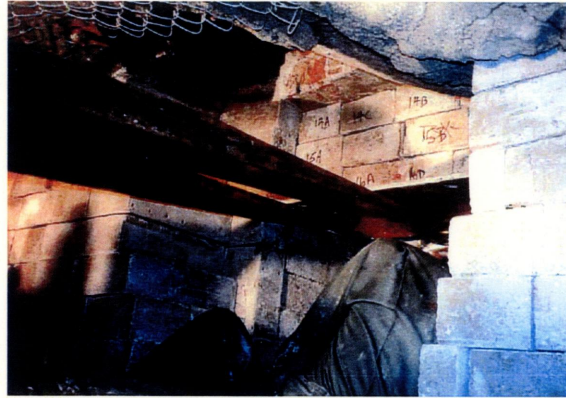
図-4.20 粘土プラグの施工状況 (PHASE8 の STEP3)
