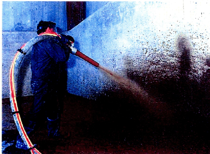
図-3.12 吹付け予備試験状況
