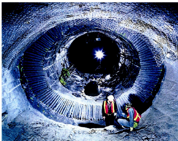
図 4.5 掘削された試験坑道の切り欠き（粘土プラグ側）
