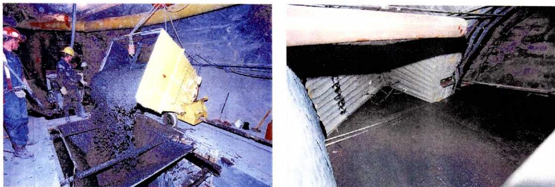
図-付3 コンクリートの打設
