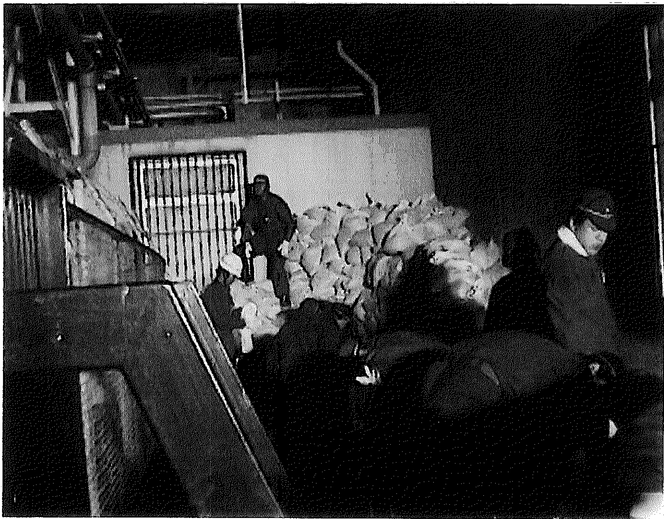
写真-2 遮へい用土のう積み作業
