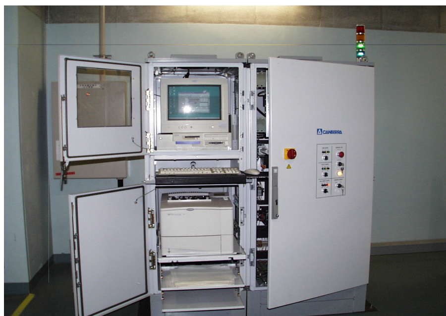
写真 2.4 操作キャビネット
