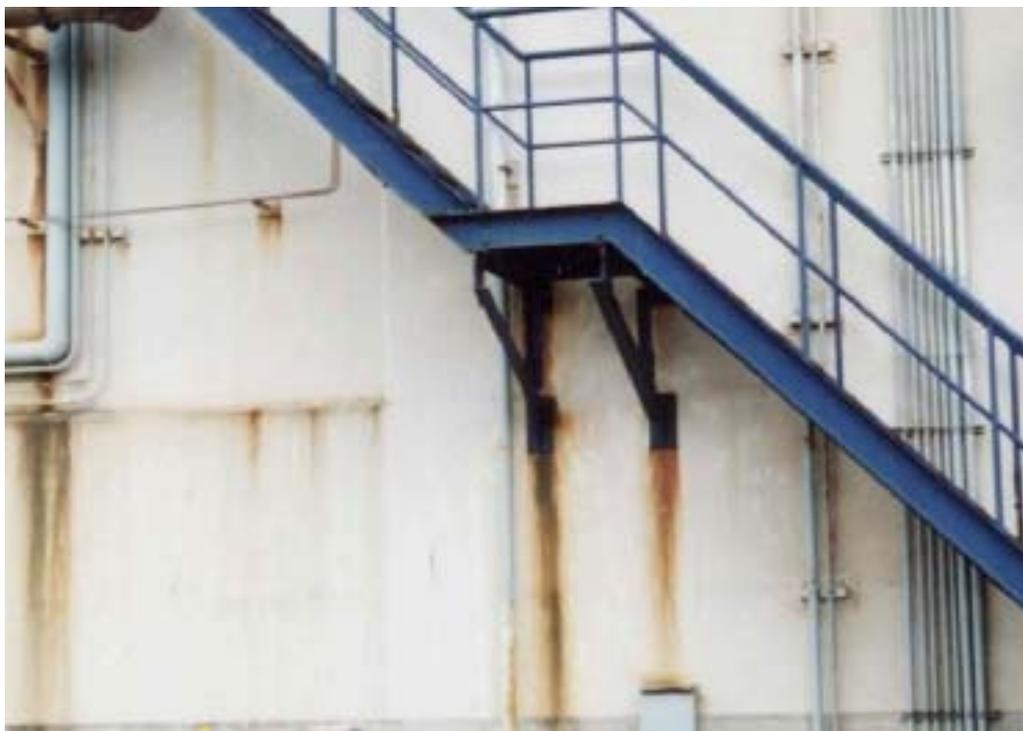
写真 5.3.2 外部階段の発錆状況写真（1992 年 12 月）
