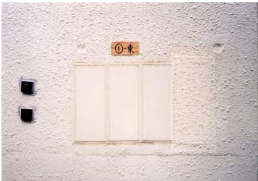
写真 7.3.2 - 1 外装材モニタリング試験体設置状況写真
