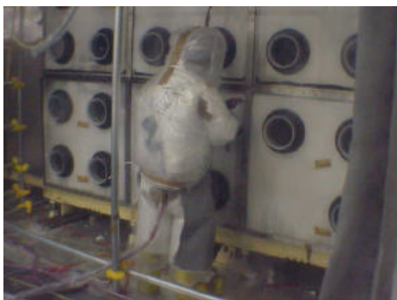
グローブボックス解体作業
