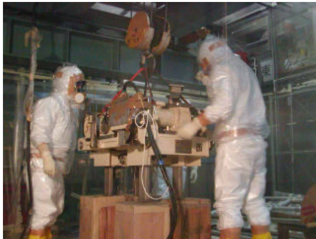
図 3.3 1.6t クレーン台車点検作業
