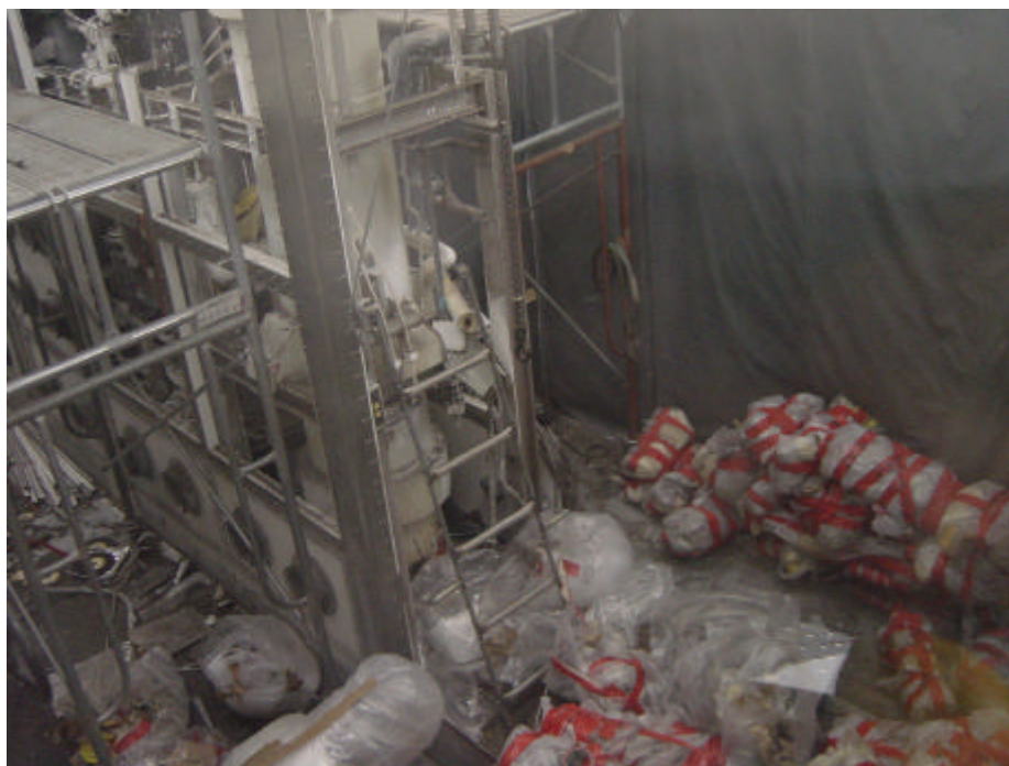
図 3.11 難燃物焼却設備の解体作業風景
