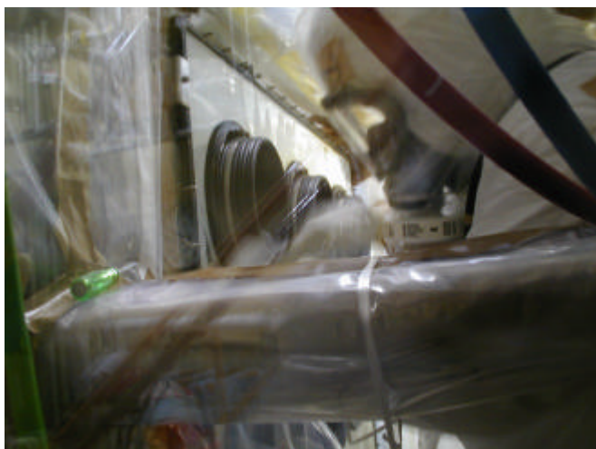
図 3.4 アクリル板の更新
